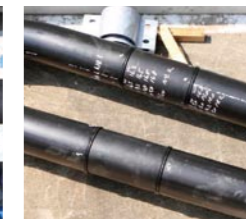
直管と加工管の接合部
