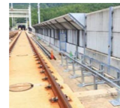
配管架台も同様に工場製作したものを現場で固定
