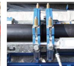
現場では電気溶接で配管接続
