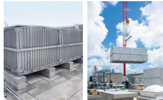
水畜熱槽交換作業
