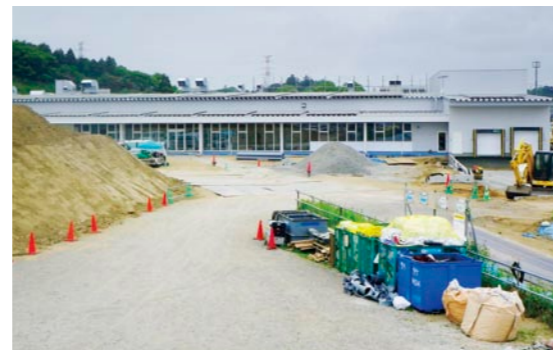
復興(新築)工事中の水産加工工場
