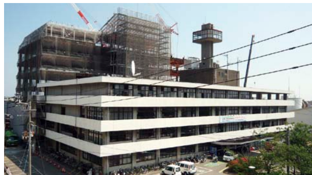
建設中の阿南市新庁舎
