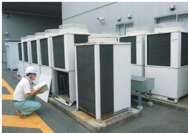
対象機器の点検
