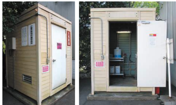
少量危険物貯蔵取扱所
