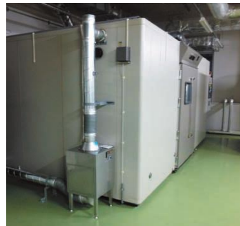
研究施設で採用されたVOC除去システム(処理風量150m 3 /h)
