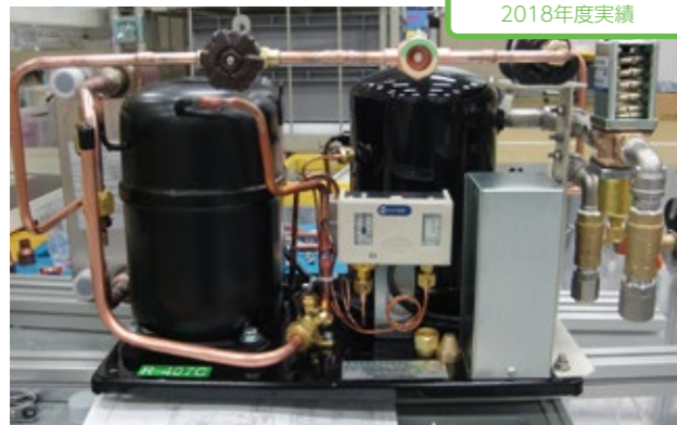
R407c(オゾン層破壊係数ゼロ)を冷媒とする冷凍機
