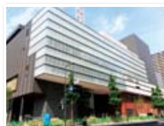
施工現場 新築、保守、リニューアル
