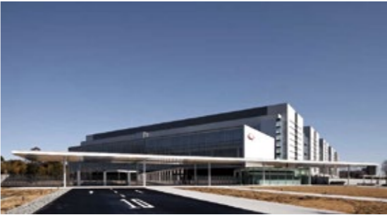
武田薬品工業株式会社湘南研究所 (現湘南ヘルスイノベーションパーク) 2011年施工
