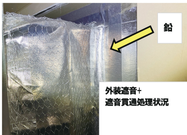
図3 外装遮音及び遮音貫通処理
