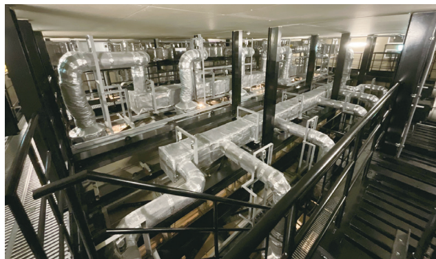
図4-2 ホール上部 ダクト鉛巻き施工 (全景)
