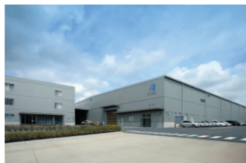
機器事業部工場 [ 開発、設計、製造、設置、保守 ]
