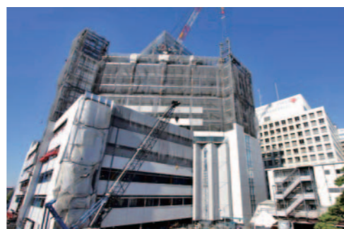
施工現場 [ 新築、保守、リニューアル ]
