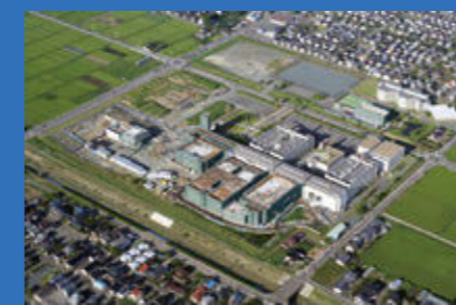
▲二次事業工事中
