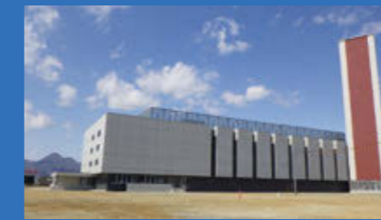
▲エネルギーセンターの全景
