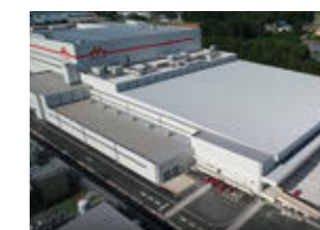
森永乳業株式会社 利根工場新製造棟 2019年施工
