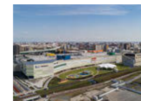
ららぽーと名古屋 みなとアークス 2018年施工
