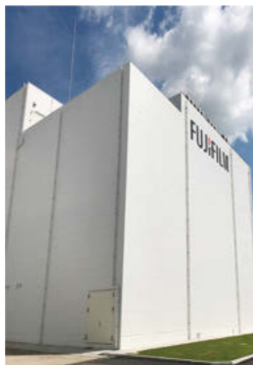
富士フイルム和光純薬株式会社 三重工場 第二製剤棟
