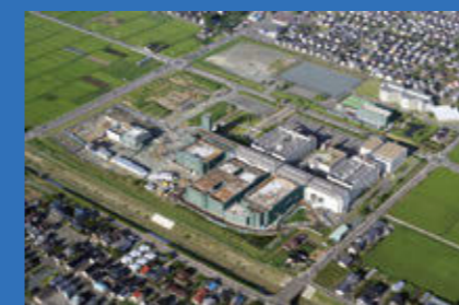
▲二次事業工事中
