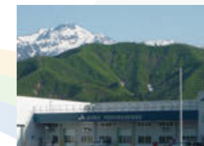
JA北魚沼利雪型米穀低温貯蔵施設 2012年施工
