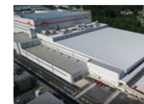
森永乳業株式会社 利根工場新製造棟 2019年施工
