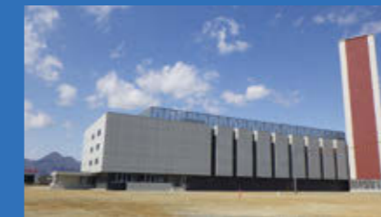
▲エネルギーセンターの全景
