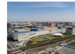
ららぽーと名古屋 みなとアークス 2018年施工
