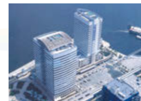
竹芝ふ頭再開発第3期 1995年施工
