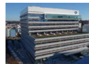
藤沢市新庁舎 2017年施工
