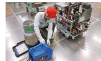
フロン類の回収作業の様子
