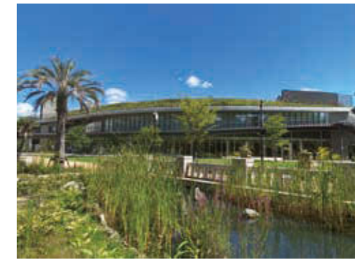
宝塚市立文化芸術センター 竣工年月:2019年9月 所在地:兵庫県宝塚市武庫川町
