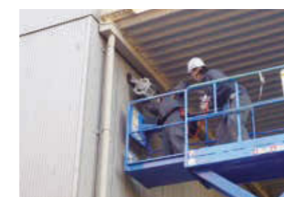
工場LED化(施工中)
