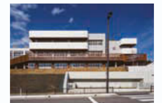
宮城県東松島市立鳴瀬桜華小学校 2021年施工
