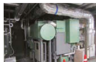
吸収式冷凍機の更新
