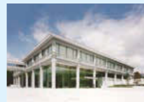
広島平和記念資料館(東館) 1994年施工
