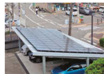
大阪支社駐車場屋根に設置
