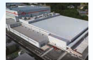
森永乳業株式会社 利根工場新製造棟 2019年施工
