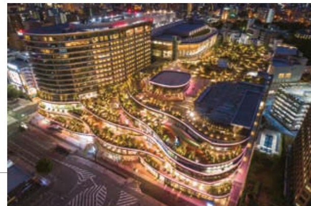
SAKURA MACHI Kumamoto 竣工年月:2019年12月 所在地:熊本市中央区桜町
