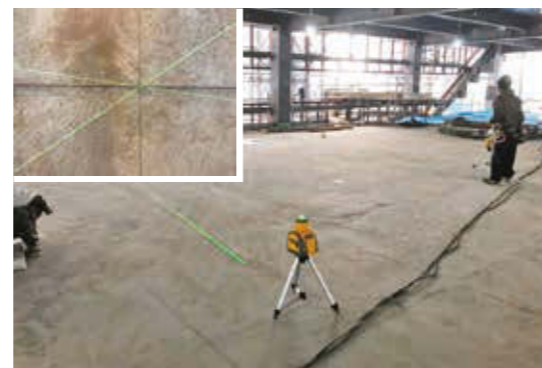
レーザー墨出しの様子
