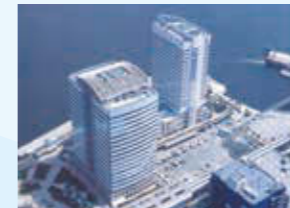
竹芝ふ頭再開発第3期 1995年施工
