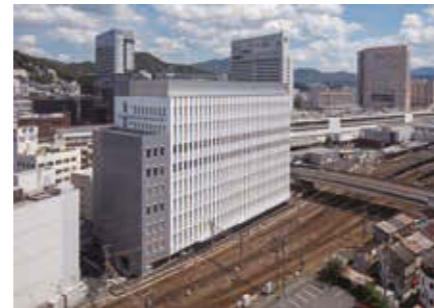
JR西日本 広島支社 竣工年月:2020年10月 所在地:広島市東区上大須賀町
