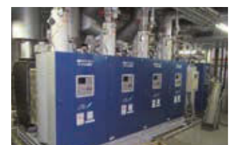
蒸気ボイラの更新
