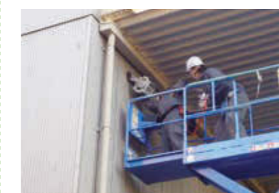
工場LED化(施工中)
