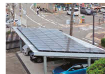
大阪支社駐車場屋根に設置
