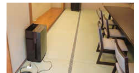
HEPAフィルタ付き空気清浄機の設置例
