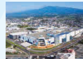
ららぽーと沼津 2019年施工
