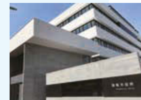
周南市役所 2019年施工
