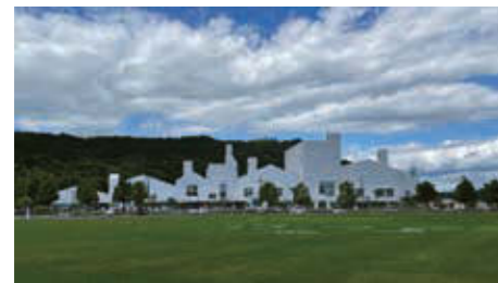
マルホンまきあーとテラス 石巻市複合文化施設 竣工年月:2021年1月 所在地:宮城県石巻市開成
