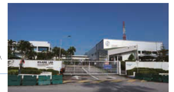
NICHIA (MALAYSIA) SDN.BHD. クリーンルーム空調改修工事 施工年月:2020年10月 所在地:マレーシア セランゴール州
