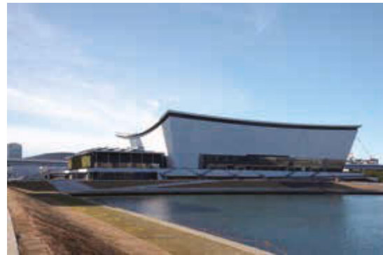
有明アリーナ 提供:東京都 竣工年月:2019年12月 所在地:東京都江東区有明
