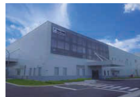
台湾東嘉瑞機能膜股份有限公司 竣工年月:2019年6月 所在地:台湾 高雄市
