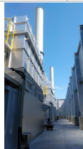
■ ← 設置後の様子
