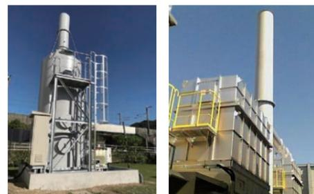
薬液洗浄式脱臭装置 蓄熱燃焼式脱臭装置
