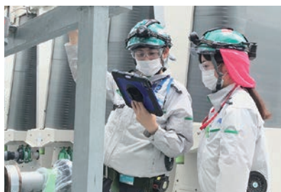
タブレット型端末による施工管理
