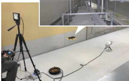
屋内狭所空間でのドローンの活用
