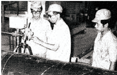
当時の作業風景
