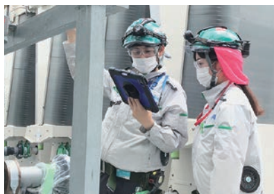
タブレット型端末による施工管理
