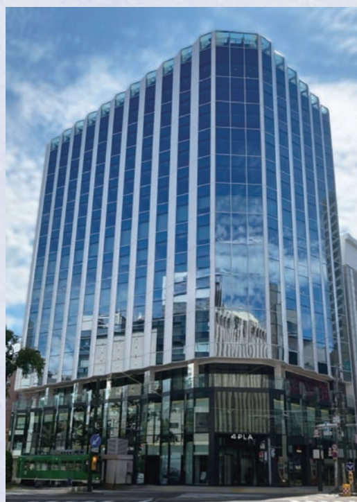
■ 札幌4丁目プレイス 竣工年月：2025年3月 所在地：北海道札幌市中央区 建物用途：商業施設、オフィス
