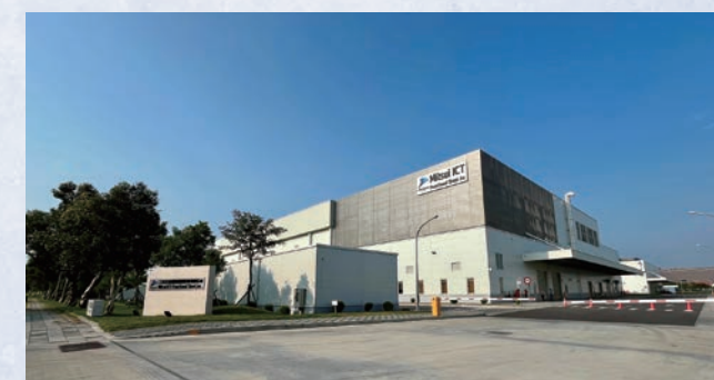
■ 三井艾喜緹機能膜股份有限公司 第2期工場追加工事 竣工年月：2024年11月 所在地：台湾 高雄市 建物用途：化学工場
