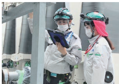
タブレット型端末による施工管理
