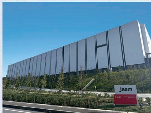
■ JASM 第一工場 竣工年月：2024年2月 所在地：熊本県菊池郡菊陽町 建物用途：半導体工場
