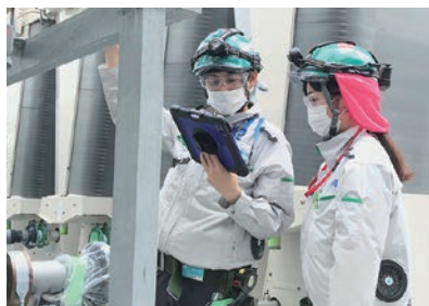
タブレット型端末による施工管理
