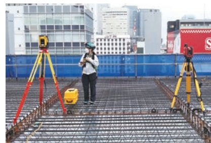
自動墨出しシステムによるレーザー墨出し
